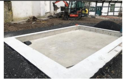
Der hintere Eingangsbereich und das Fundament für die Behausung des Töpferofens
